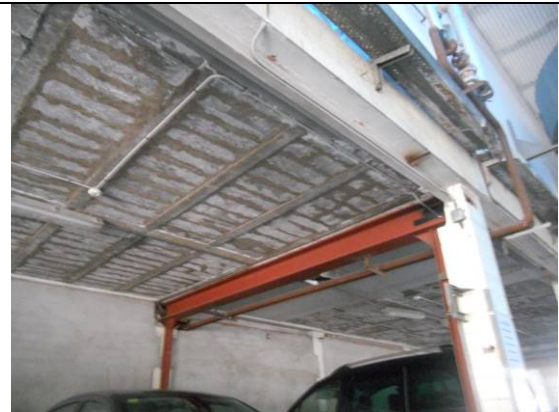
Vista int., reforç sostre unidireccional biguetes.
