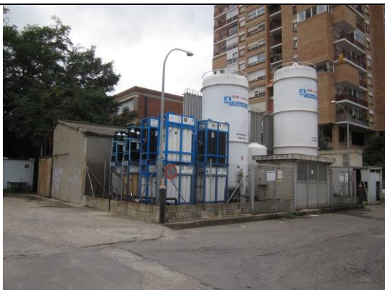
Vista general "Edificis aïllats"
