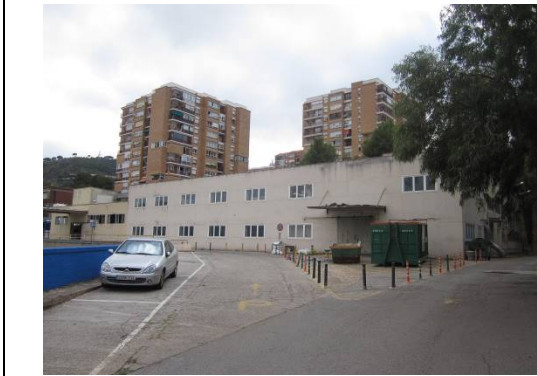
Vista general de l'edifici "bugaderia", façana sud
