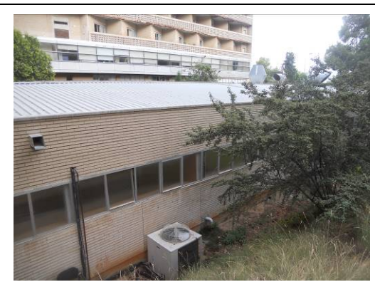
Vista façana i coberta nord.
