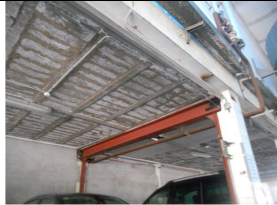
Vista int., reforç sostre unidireccional biguetes.
