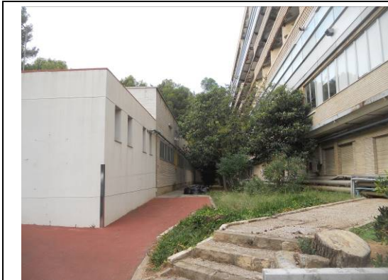
Vista general "annex Escola Infermeria" (esquerra)
