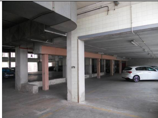
Vista interior, diversos sistemes estructurals
