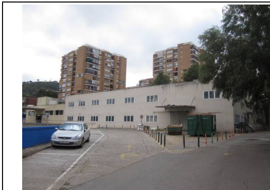
Vista general de l'edifici "bugaderia", façana sud
