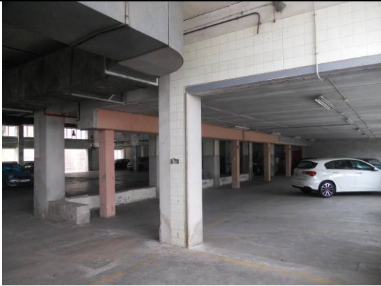
Vista interior, diversos sistemes estructurals
