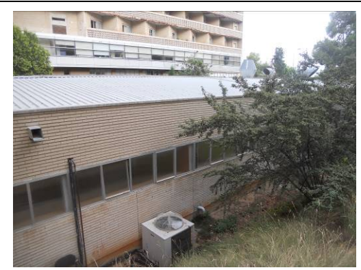
Vista façana i coberta nord.
